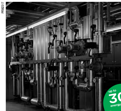
Управление насосной станцией
